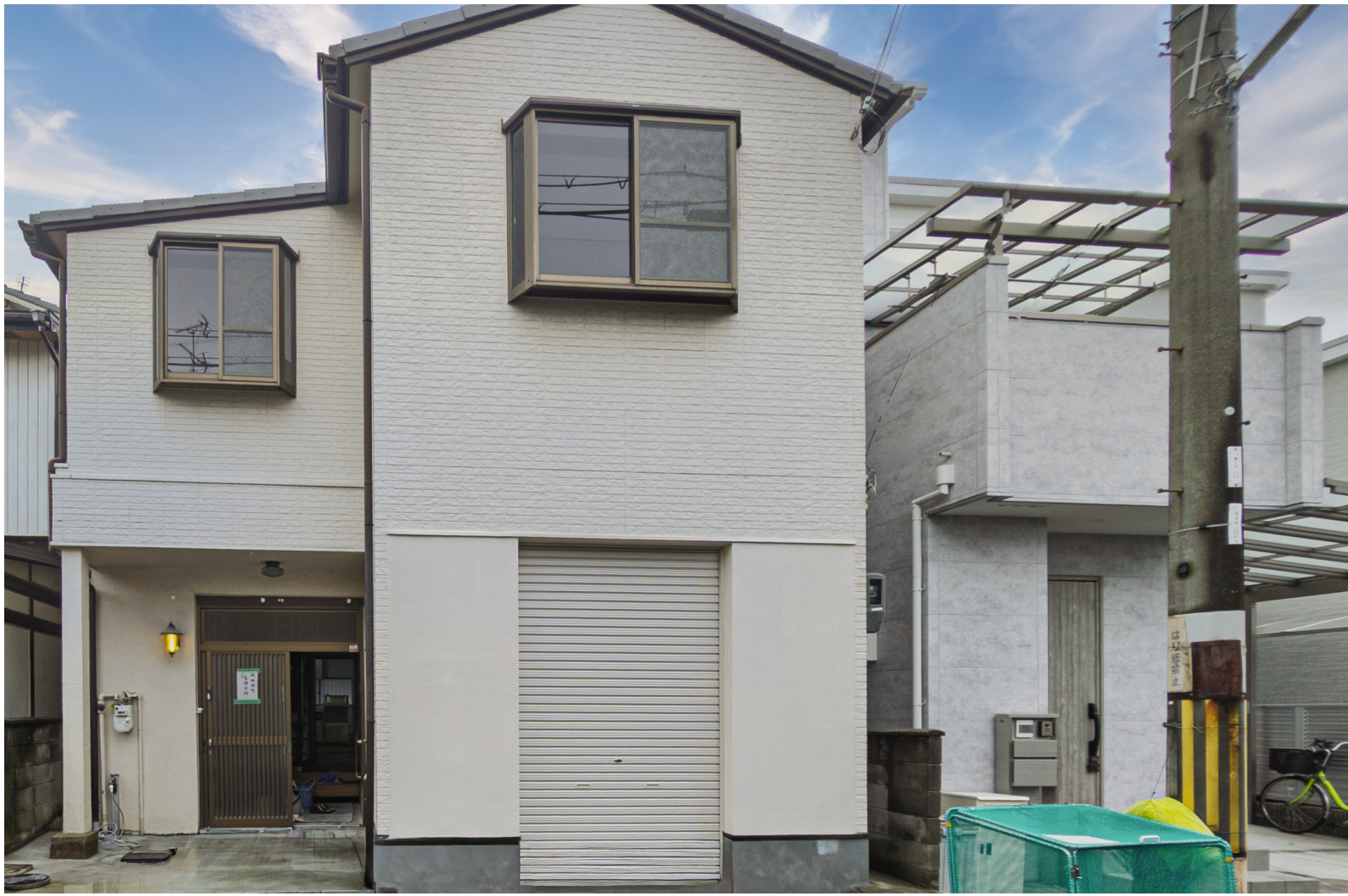
成田西町自治会館 完成間近
